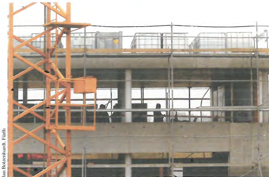
Abb. 2: Bürogebäude der Fa. Schiebel in Gaimersheim mit dem Wasserbehälter für die Probelastung.
