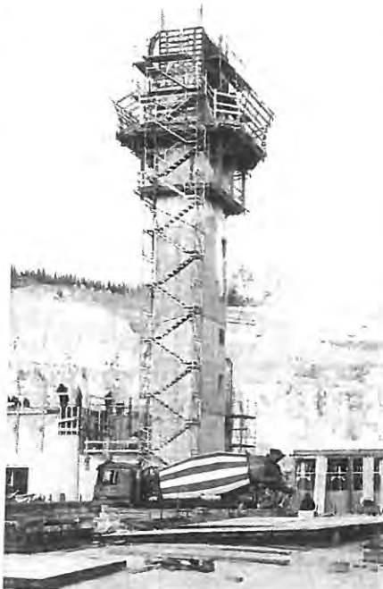
33 m hoher Betriebsgebäudeschacht in Kletterschalung: Um das geforderte Fugenbild und die vorgeschriebene Bewehrungsführung einzuhalten, wurde in fünf Klettertakte mit je 6,00 m und einem Takt mit 2,80 m Höhe geschalt und betoniert (Photo: MEVA)
