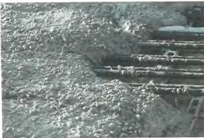
Bild 4 Kombination Vorspannung mit Stahlfaserbeton
