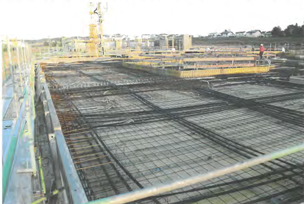
Bild 1 Spangliedführung in der Geschossdecke
