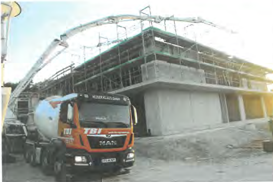
Bild 3 Pumpen des Stahlfaserbetons
